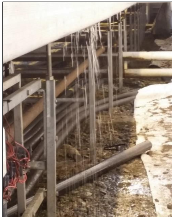
Høyre; Sprekker i bordplate. Begge foto Liv Knudtzon.
