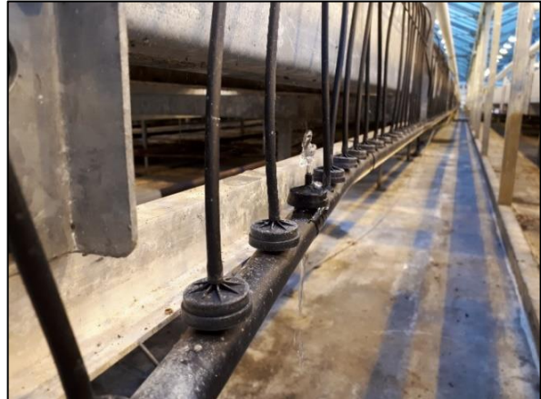
Venstre. Vannslange som har kommet skjevt på rennen. Her er det satt opp oppsamlingsrenne så vannet fra den skjeve slangen samles opp og ledes tilbake i retursystemet. Høyre. Lekkasje i festet for vanningslangen. Foto Astrid S. Andersen
